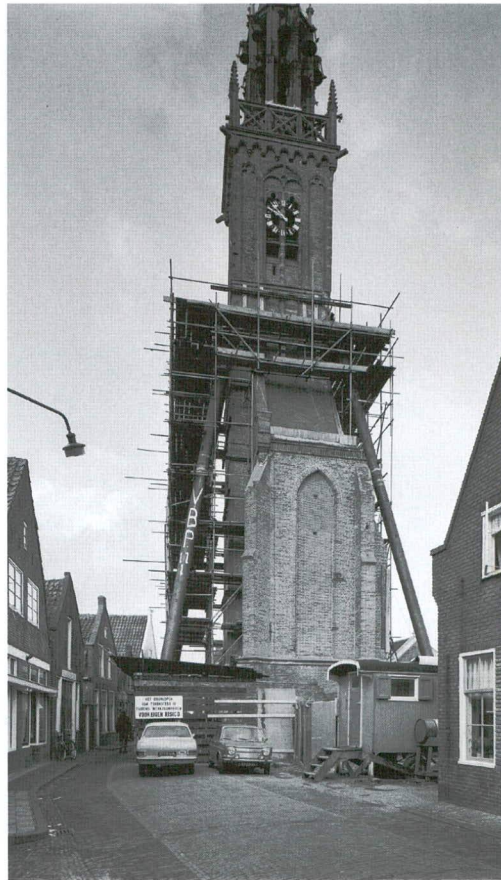
De Speeltoren tijdens de restauratiewerkzaamheden in 1973 (foto: G. Drukker, RCE).
