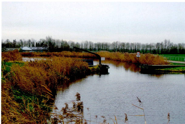
§ Damsluis in de Waver, aangelegd in de Koude Oorlog.
