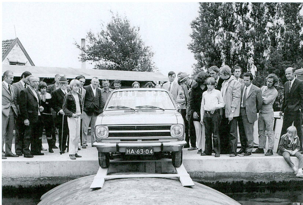
Een opgeblazen balgstuw in de omgeving van Aalsmeer. Bron: Archieven Provinciaal Bestuur van Noord-Holland, Archief Waterstaat, Fotoarchief 1892-1973.
