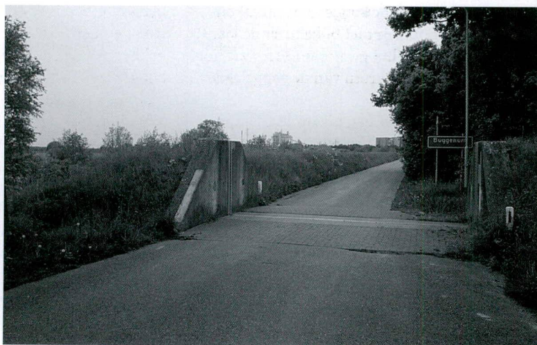
Coupure in de nieuwe kade die na het hoge water van 1995 is aangelegd. Rechts verloopt de kade in de hogere gronden. Foto Harrie Sleutels.
