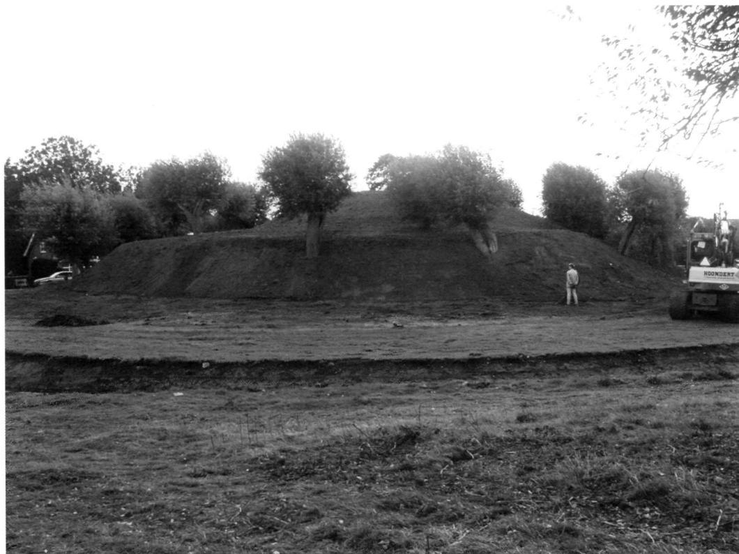
Inrichtingswerkzaamheden Borssele-Berg van Troje: aanhelen van de berg en uitgraven van gracht.
