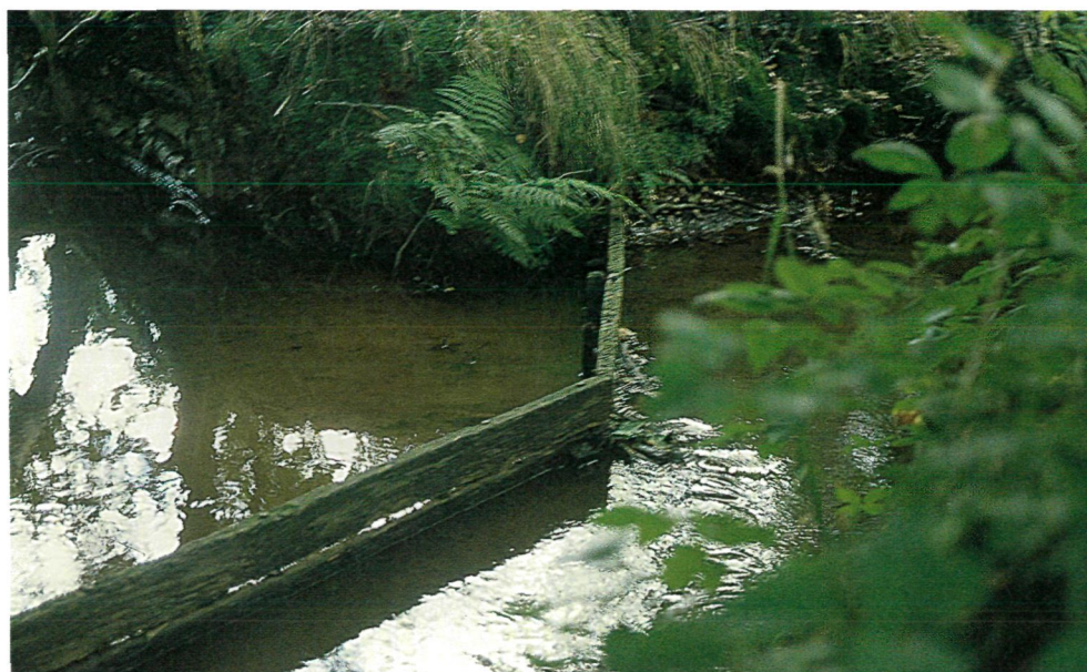
Het aquaduct van de Geelmolenbeek, die hier over de Nieuwe Beek heen wordt geleid.
