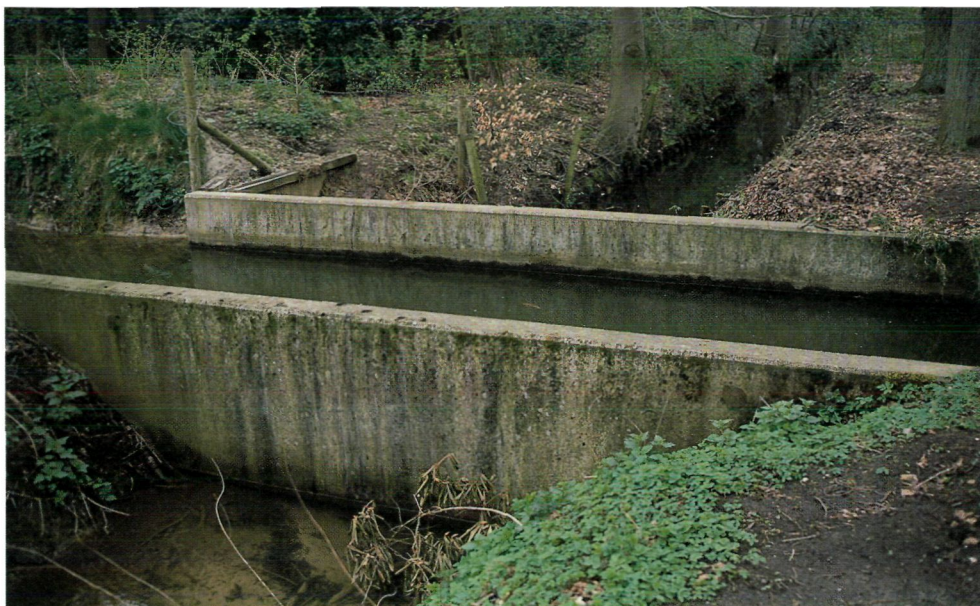
Het aquaduct van de Geelmolenbeek, die hier over de Nieuwe Beek heen wordt geleid.
