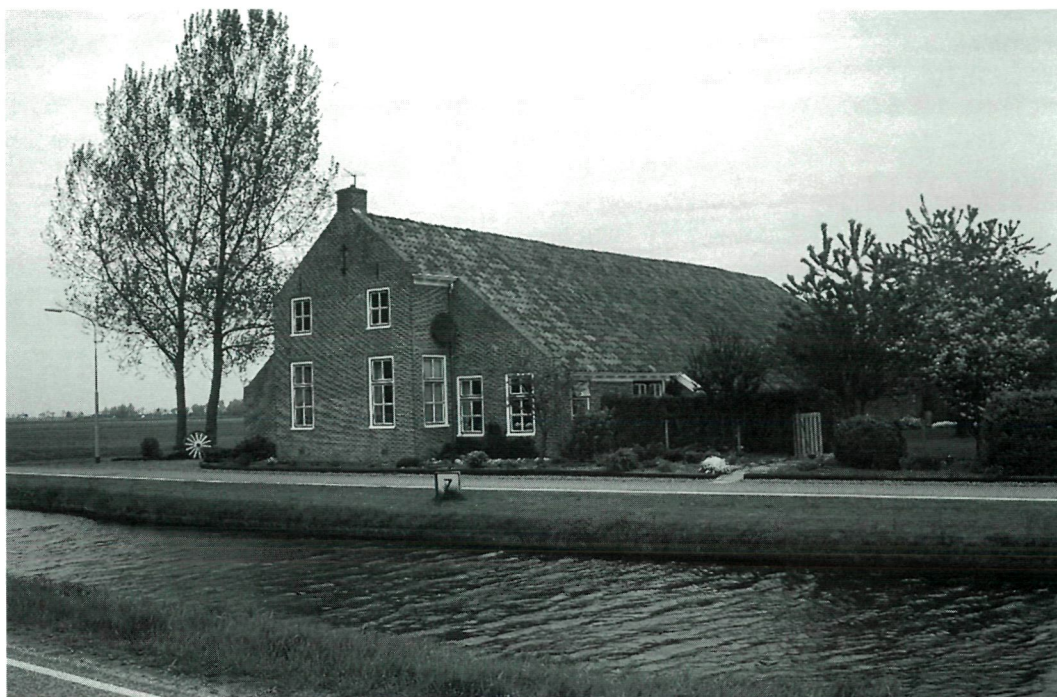
Typische veenkoloniale boerderij in Kiel-Windeweer. Dankzij het uitgebouwd voorhuis heeft men een goed uitzicht op het kanaal (foto Taeke Stol).
