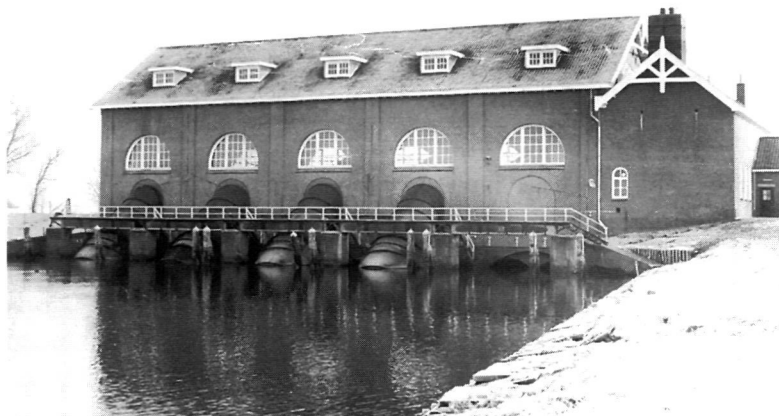
Gemaal Electra (foto: Klazien Schroor).
