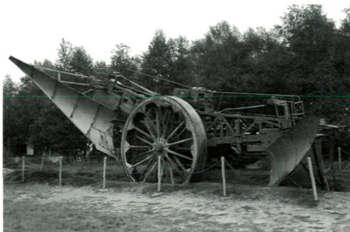
5. 'Mammoetploeg' uit 1950 met een turfgraafmachine in het Moormuseum. De 'Mammoetploeg' kon tot 2,20 meter diep ploegen en kon maximaal 2 hectare grond per dag omzetten. De ploeg werd door twee, bij zeer diep ploegen zelfs door vier, locomobielen aan een kabel over het terrein getrokken (foto auteur).
