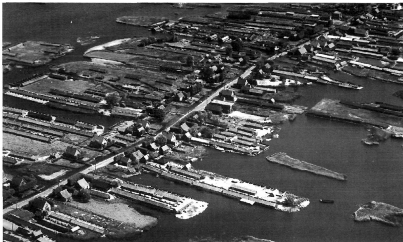
Luchtfoto van Waterland bij Den IJp uit 1936 met opvallend veel kippen- en eendenhokken (foto: KLM Aerocarto).
