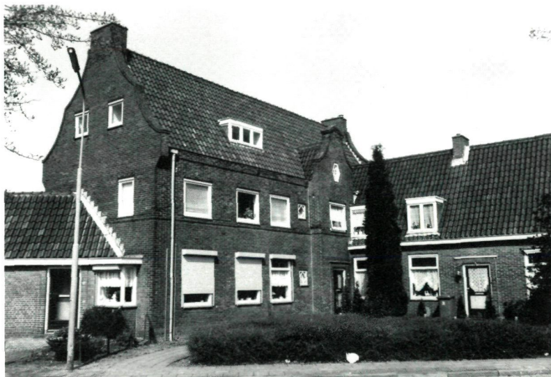
Poortlaan 48 t/m 52. Opvallend zijn de in- en uitzwenkende kopse gevels (Foto A. Ruijs, gemeente Ede).
