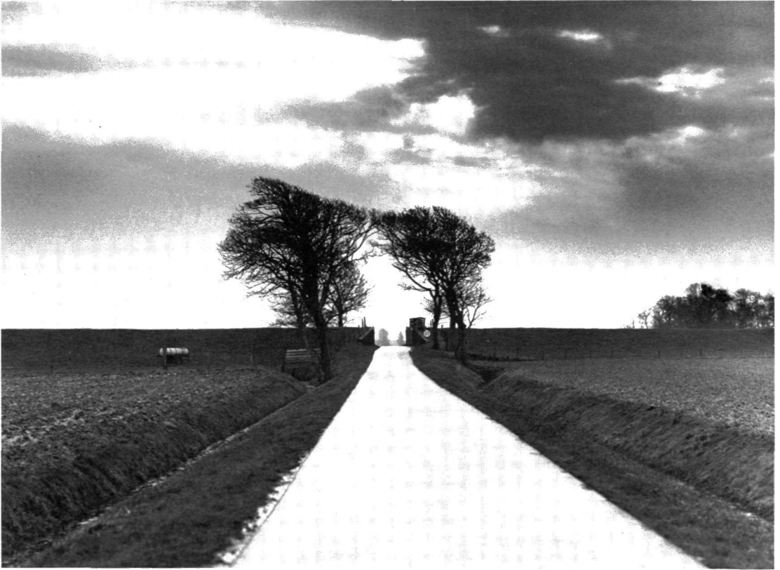
Een schotbalkcoupure in de Uithuizer polderdijk (Groningen) (foto Jur Bosboom, provincie Groningen).
