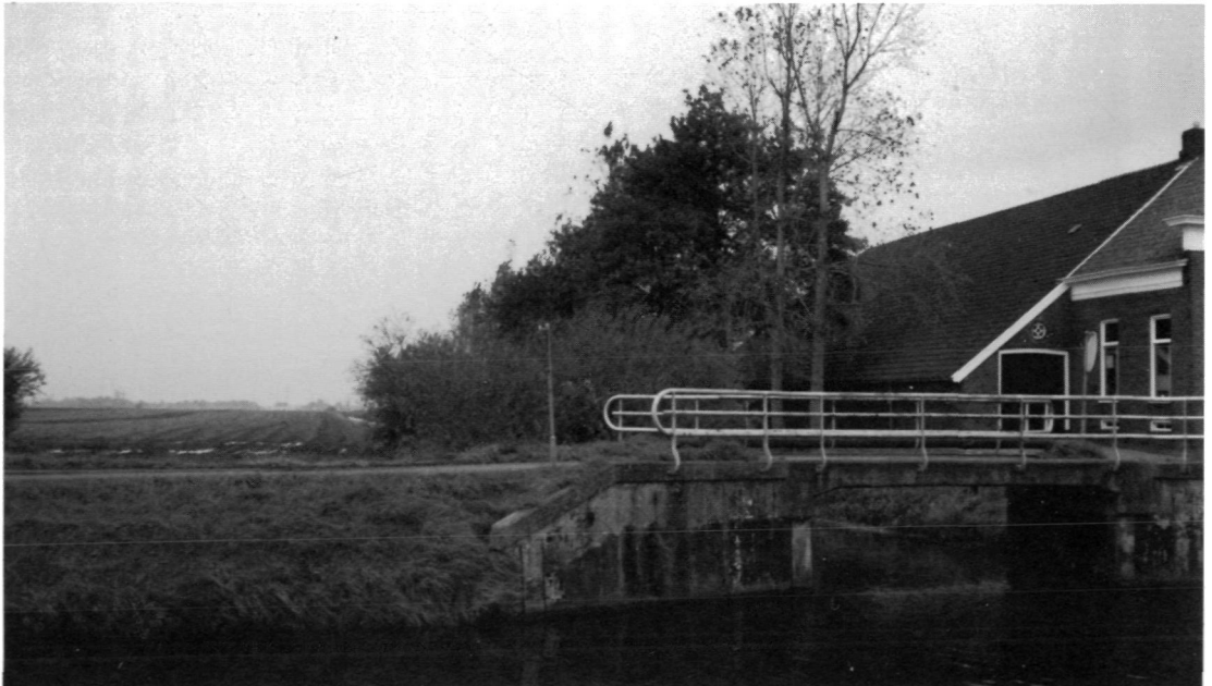
Een wijk staat loodrecht op het diep. Het gebied tussen twee wijken, de “plaats”, werd na vervening geschikt gemaakt voor landbouw.
