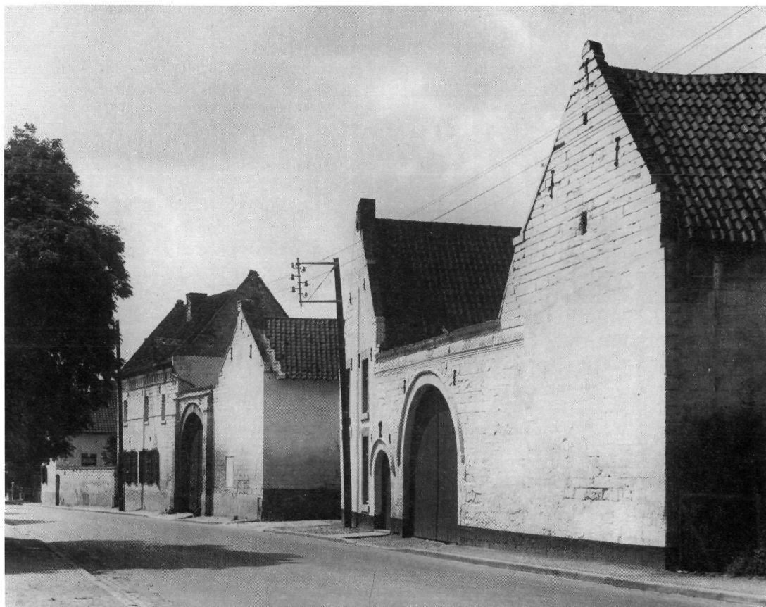
Foto b. St. Gerlach, Provinciale weg 22 (“Croon”, 1660-’63) en 20 (“In de Bol”, 1683) met de tussengelegen uitmonding van de Gouden Roodweg, eertijds Vauwerstraat. Foto: Rijksdienst voor de Monumentenzorg, ca. 1940.
