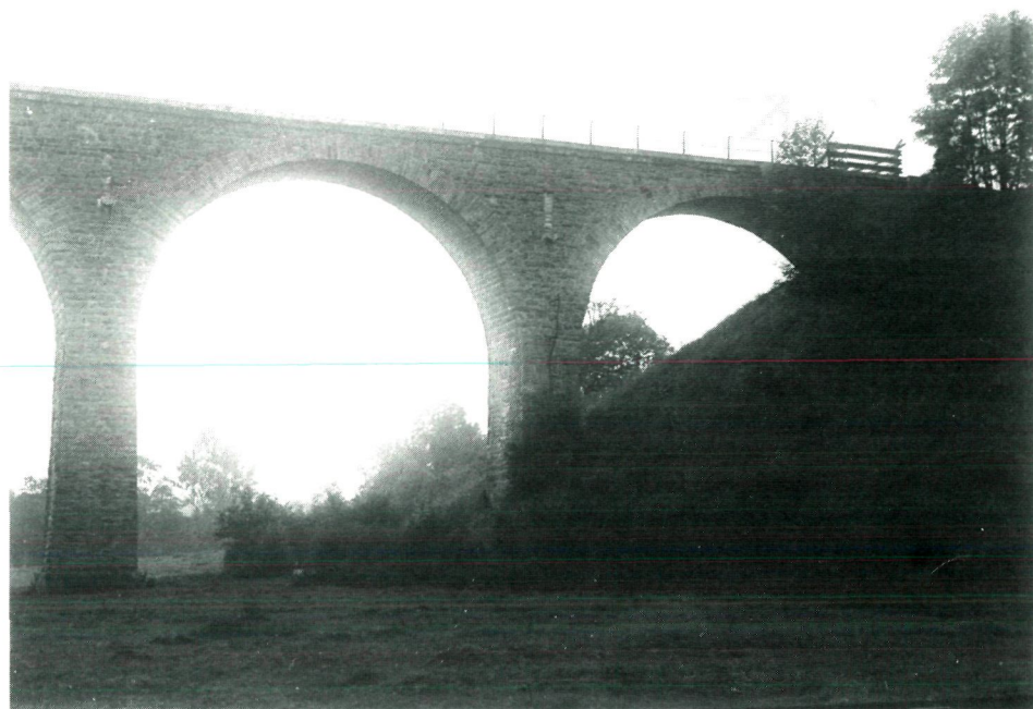
Figuur 5. Natuurstenen viaduct in de spoorlijn van Stolberg naar Raeren (België).
